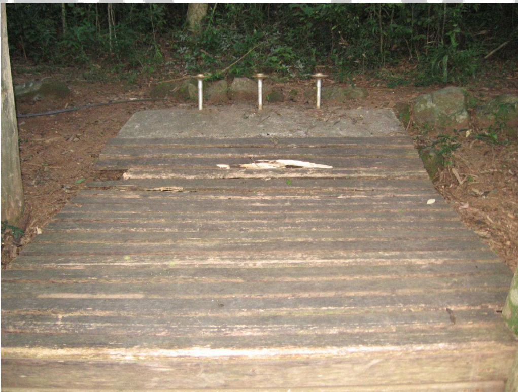
Imagem 4 - Deque da ancoragem
