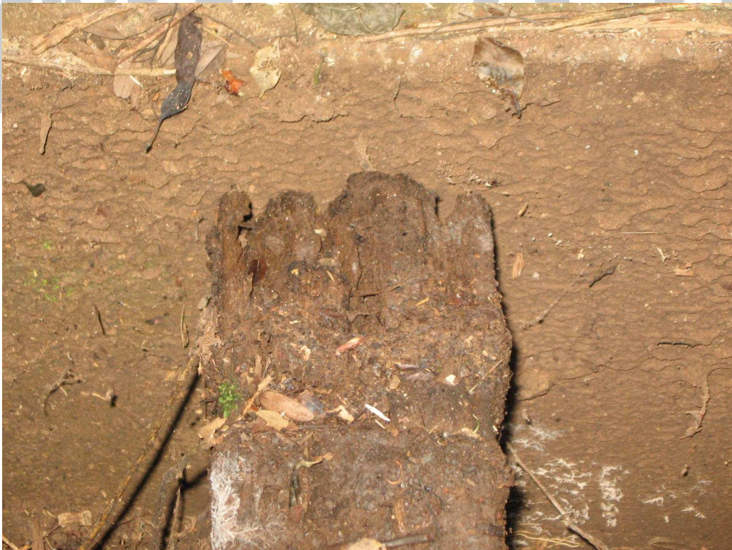
Imagem 10 - Detalhe do apoio da tampa
