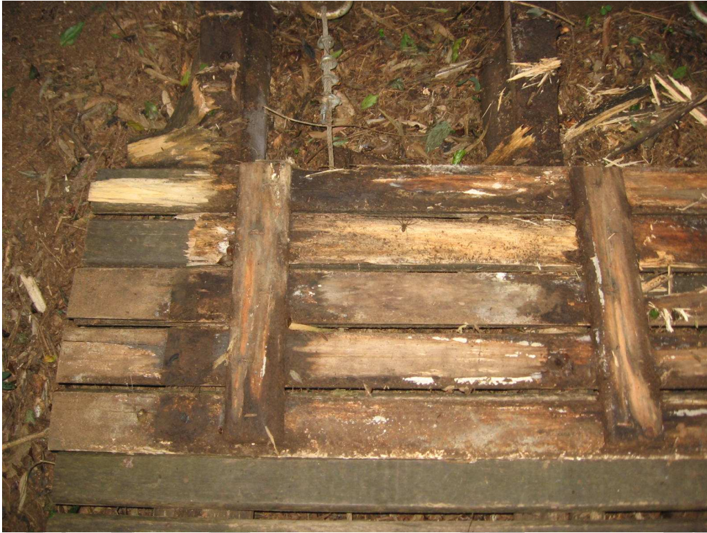
Imagem 7 - Vista parcial da parte inferior da tampa
