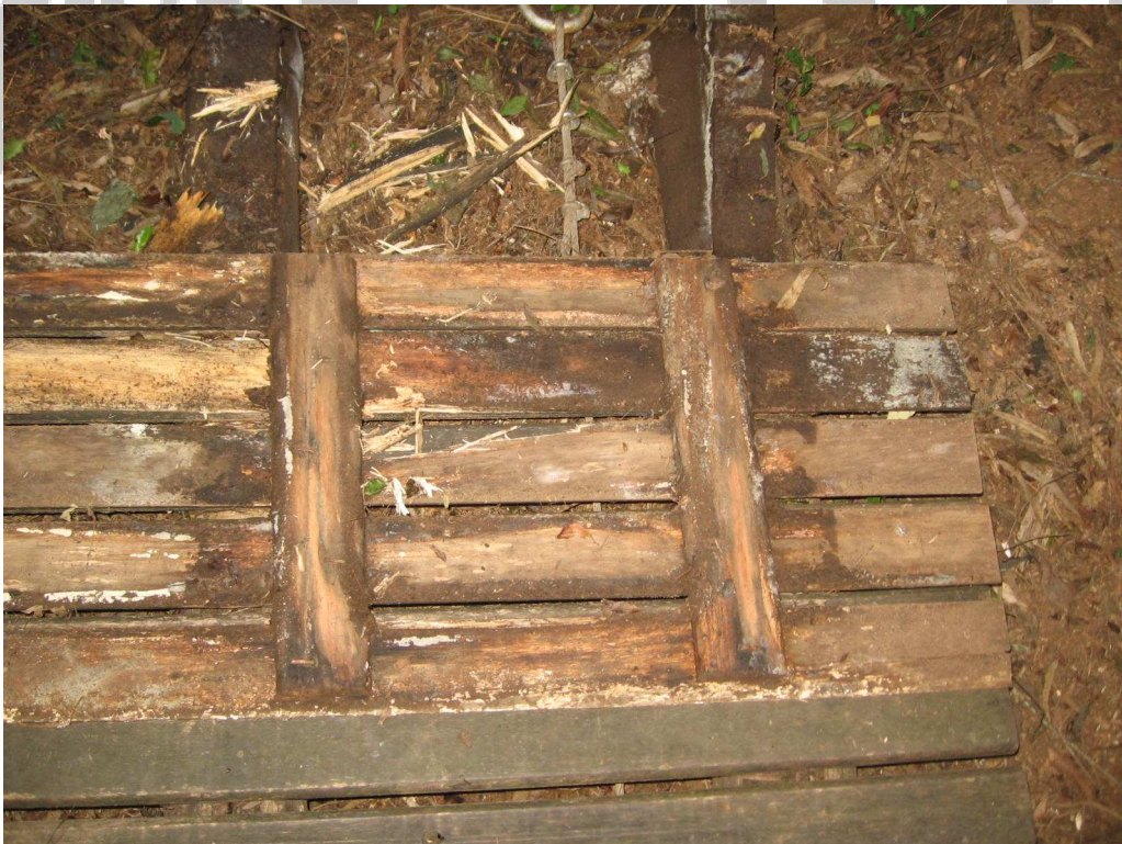
Imagem 6 - Vista parcial da parte inferior da tampa
