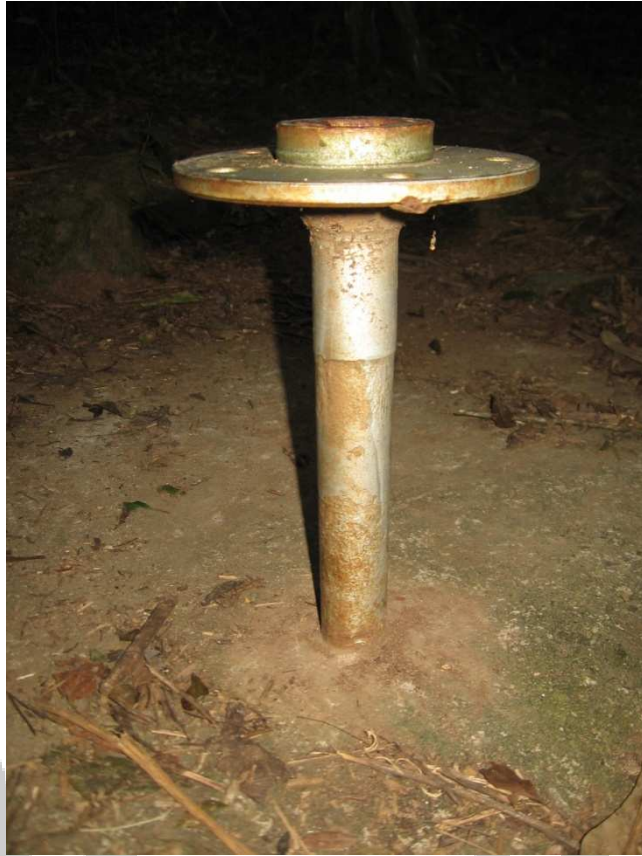
Imagem 3 - Barra de Ancoragem (lado acesso)
