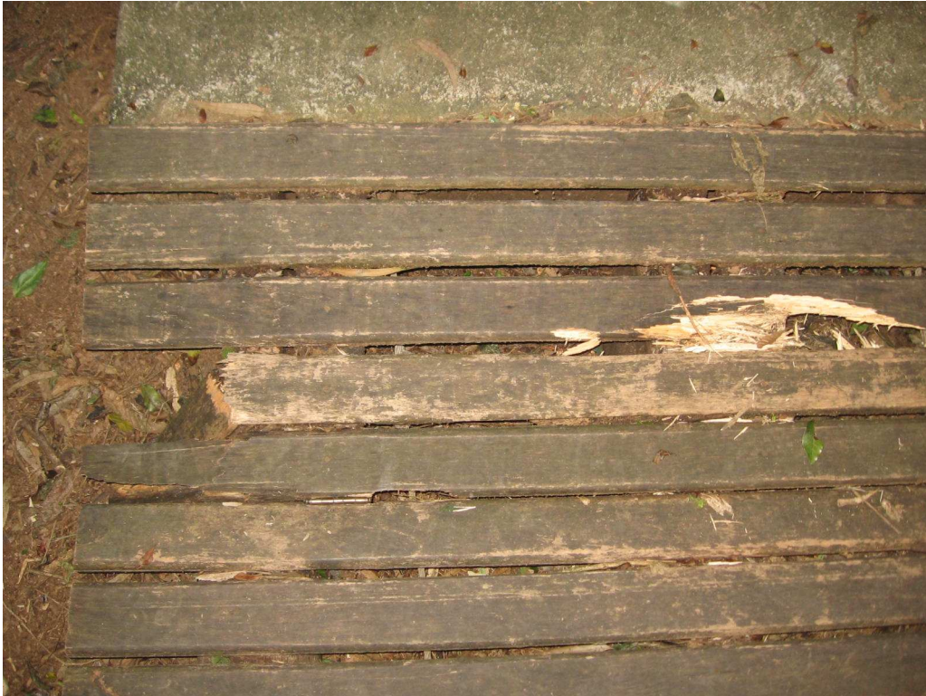
Imagem 5 - Tampa com partes quebradas
